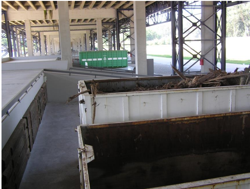
Figura 5: Parque de armazenagem temporária de resíduos
