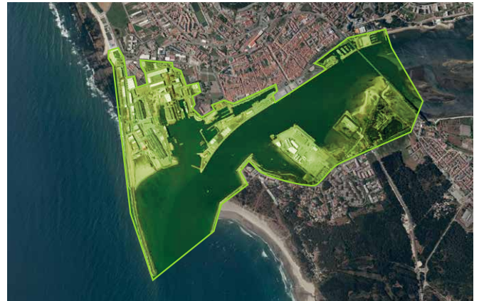
Figura 14. Área de jurisdição do Porto de Viana do Castelo
