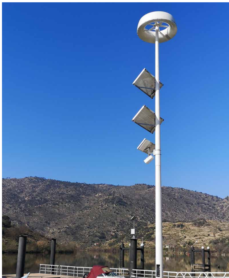
Figura 4. Exemplo de iluminação pública com energia solar e eólica na VND
