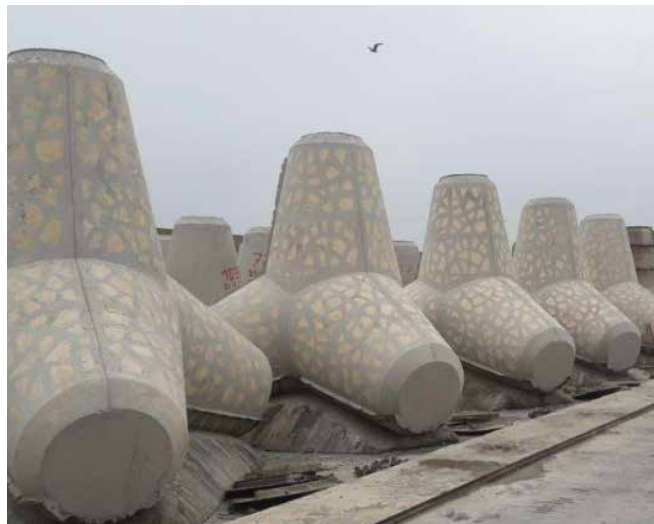
Figura 6. Tetrápodes EONcrete no Porto de Leixões
